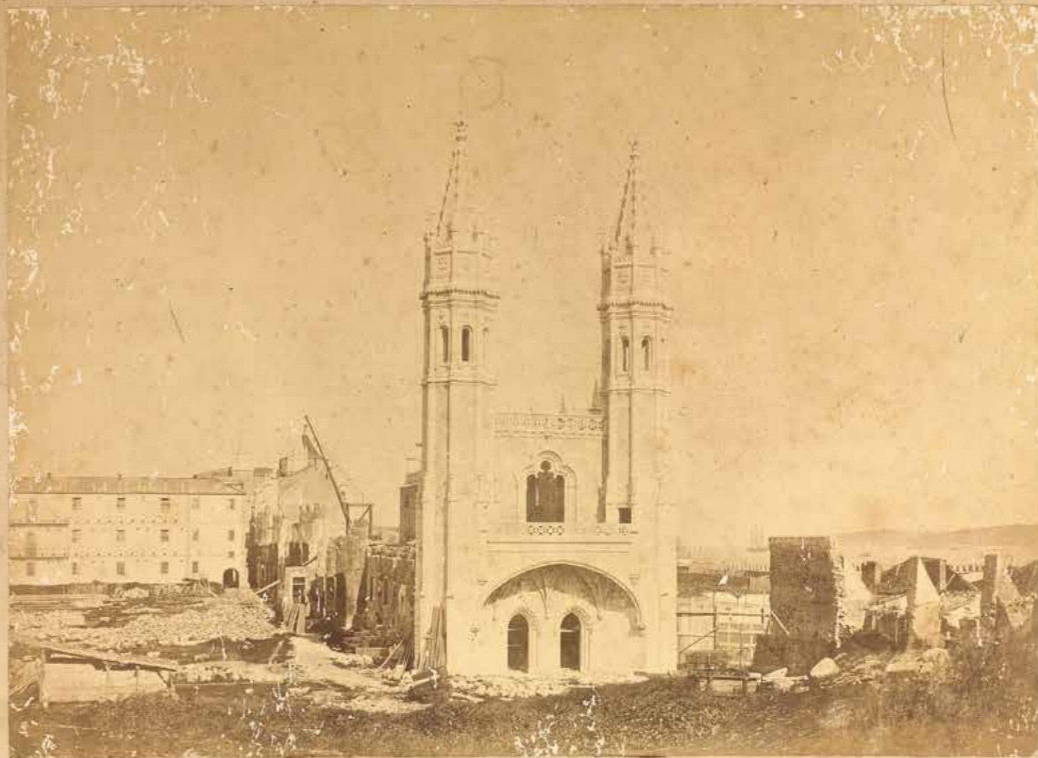
Jeronimos - Obras de reconstrução do dormitório - Fachada ocidental.
